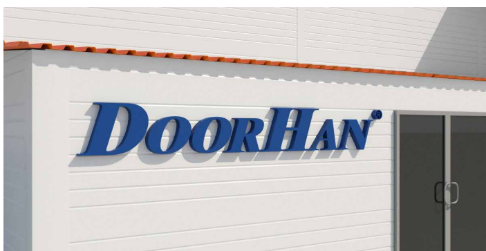
Фасад. Вид днем
