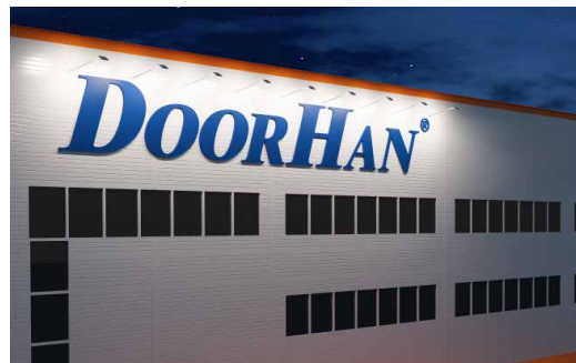
Фасад. Вид ночью
