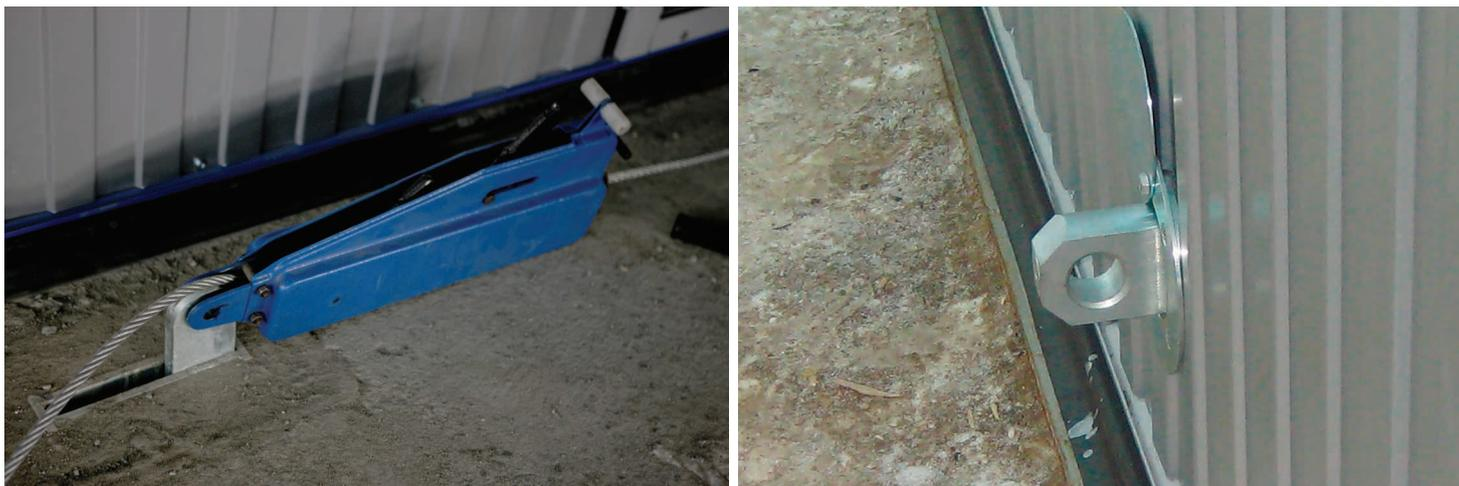
Для передвижения ворот в экстренных случаях предусмотрена возможность расцепить мотор-редукторы, вытащить специальную буксировочную сергу и передвигать полотно при помощи дежурного транспорта или лебедки.
