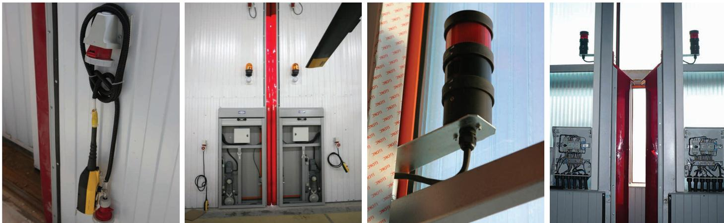
Блоки управления разрабатываются в соответствии с техническим заданием заказчика. Они обеспечивают плавный пуск и остановку по команде с переносного или стационарного пульта управления. Для обеспечения безопасности при эксплуатации ворот, во время движения полотна работает световая и звуковая сигнализация.
